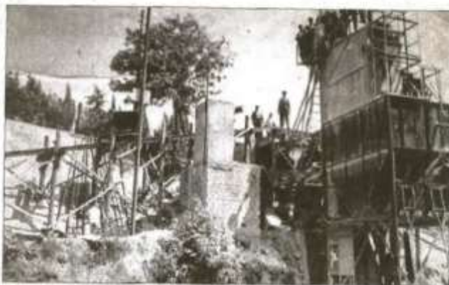
▶ Avant 1950, une entreprise de concassage de graviers.
