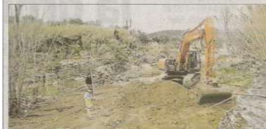
▶ Déblaiement des gravats et embâcles.
